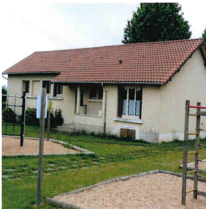
Arrière du bâtiment
